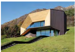
AlpsVilla, Brescia, I Camillo Botticini Architetto Domenico Belingheri, Colere (BG), I TECU® Oxid ©Photo: Niccolò Galeazzi
