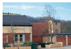
Private Residence, Nuremberg, D Haid+Partner Architekten+Ingenieure, Nuremberg Schlosserei Spenglerei Straßl, Arnstorf TECU® Bond
