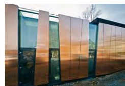
Radio-Log, Hof, D hiendl_schneis architektenpartnerschaft, Passau Franz Kraus GmbH & Co KG, Hammelburg TECU® Classic_bond
