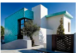
Private Residence, Sant Vincenç de Montalt, ES Marga Pérez Canal & Ana Aparicia, Barcelona KME Architectural Solutions, Sta. Perpètua de Mogoda, Barcelona TECU® Patina
